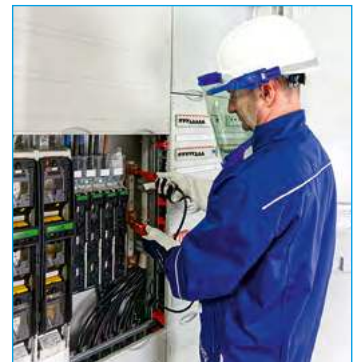
Bild 4: Überprüfen der Spannungsfreiheit mit einem zwei-poligen Spannungsprüfer
