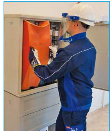
Bild 2: Abdecken spannungsführender Teile
