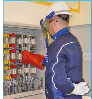
Bild 2: Elektrofachkraft beim Ziehen eines NH-Sicherungseinsatzes
