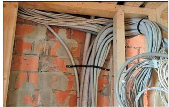
Bild 2: Elektroinstallationsrohre
