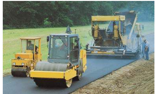
Beispiele für den Tiefbau und Straßenbau
