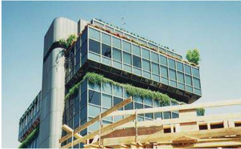
Beispiele für den Hochbau
