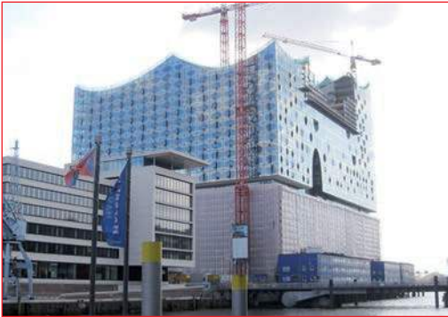
Bild 1.21 Elbphilharmonie, Hamburg, im Bau 2015
