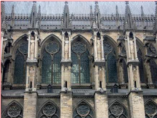
Bild 1.11 Südfassade der Kathedrale zu Reims
