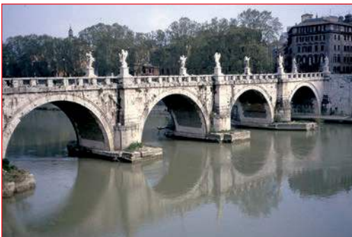
Bild 1.6 Tiberbrücke, Rom 1. Jh.
