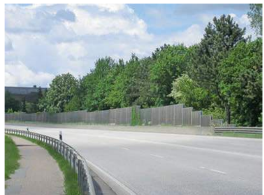
Abb. 1.8: Autostraße mit Lärmschutzwand
