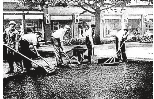
Abb. 1.7: Bau einer Teerstraße vor etwa 70 Jahren (Straßenpech) im öffentlichen Straßen- und Wegebau ist in Westdeutschland seit 1984 und in Ostdeutschland seit 1990 wegen seiner gesundheitsschädlichen Wirkung verboten.
