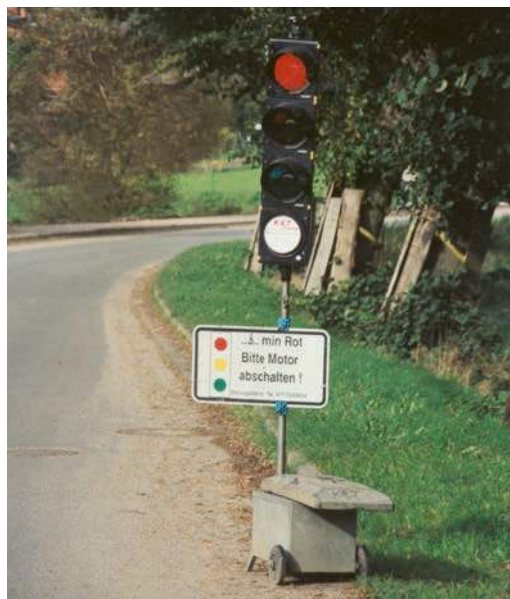
Abb. 1.16: Hier empfiehlt die Baufirma, während der langen Rotphasen den Motor abzustellen.
