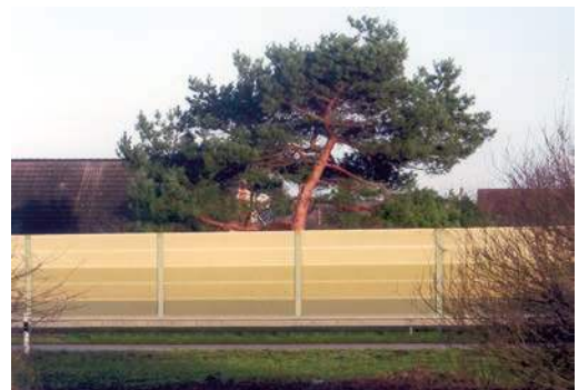
Abb. 1.13: Lärmschutzwand zwischen Wohngebiet und Bundesstraße
