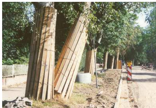
Abb. 1.15: Die Bäume werden während der Bauarbeiten geschützt.
