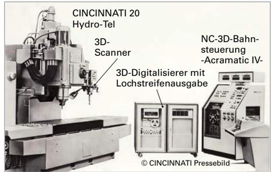
**Bild 1: Historische NC-Senkrecht-Fräsmaschine, um 1970 (Cincinnati 20 NC Hydro-Tel)**
