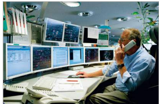
Bild 2: Netzleitzentrale (NLZ) Frankfurt am Main
